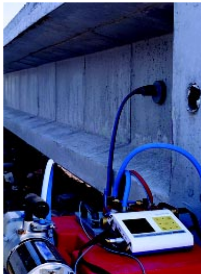
Medición in situ de la permeabilidad del hormigón
